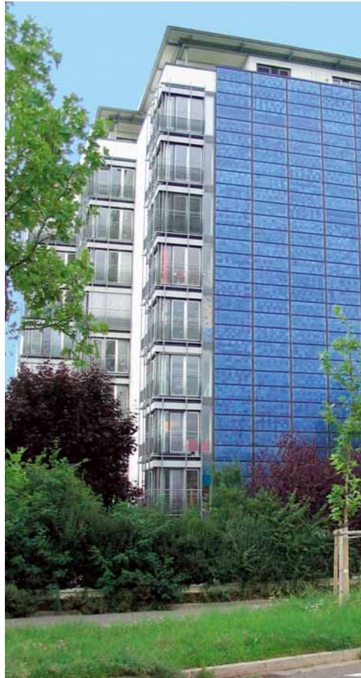
Abbildung 3 (links) Fassadenintegration farbiger Kollektoren
