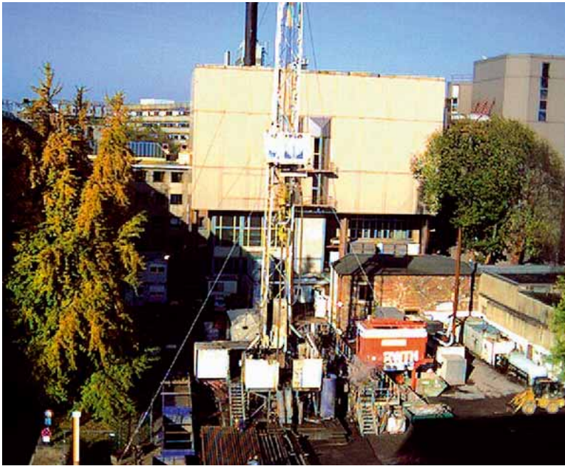
Abbildung 3 Innerstädtische Bohrung in Aachen 2004 Webkameraaufnahme
