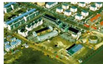
f Hannover-Kronsberg (2000) 106 Wohnungen, 1.350 m 2 Flachkollektor, 2.750 m 3 Heißwasser-Wärmespeicher
