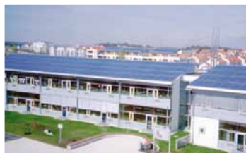
e Neckarsulm-Amorbach (1998) 5.263 m 2 Flachkollektor, 63.360 m 3 Erdsonden-Wärmespeicher
