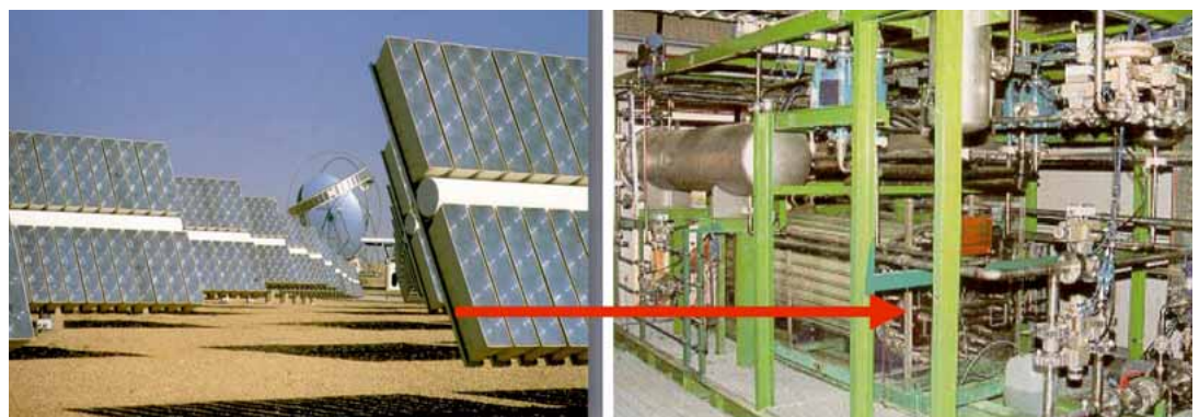
Abbildung 12 HYSOLAR 350: die erste technische Anlage zur Produktion von solarem Wasserstoff mit einer Elektrolyseleistung von 350 kW el . Solar Village, Riyadh, September 1993.
