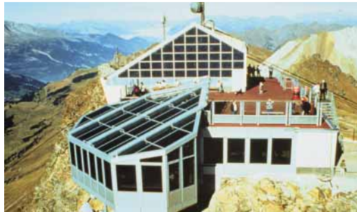
Abbildung 2 PV-Dach und Fassade © Fabrimex
