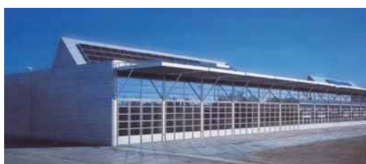
Abbildung 5 Luftkollektoren mit Photovoltaik im Industriebau © Grammer-Solar-Bau
