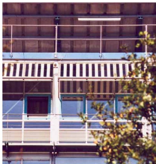
Abbildung 4 Multifunktionale Sonnenschutzmarkise mit doppelseitig lichtaufnehmenden Solarzellen und weißer, semi-transparenter Rückwand
