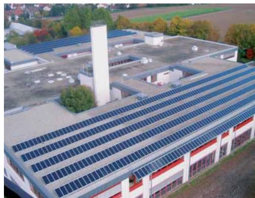
Abbildung 6 CIGS-Anlage auf dem Dach einer Schule in Marbach a.N. mit 50 kW p
