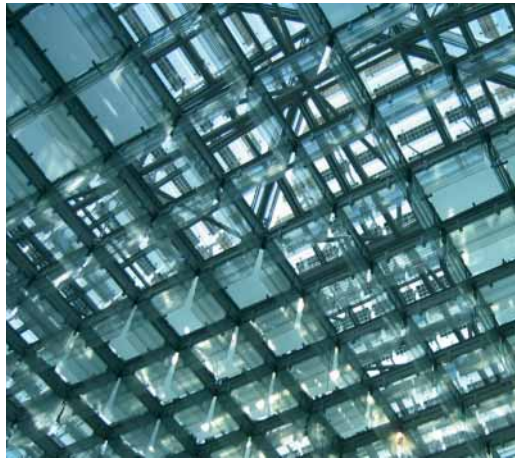
Abbildung 7a (links) Deutscher Bundesrat in Berlin mit 21 kWp Gesamtleistung: Die beweglichen PV-Ver- schattungslamellen werden mittels Schub- gestänge dem Sonnen- stand nachgeführt und dienen dem Sonnen- schutz.
