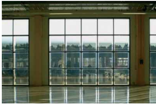
Abbildung 4 Südfassade der RWE SCHOTT Solar Fabrik, SmartSolarFab®
