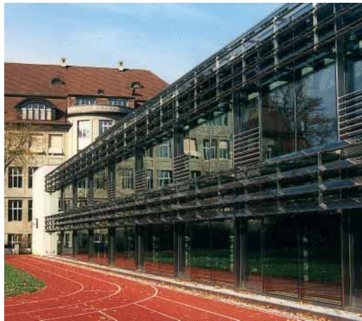
Abbildung 5a und 5b Photovoltaik-Anlage an und auf einer Schule in Stadelhofen
