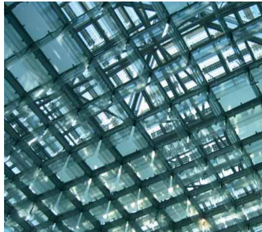
Abbildung 7a (links) Deutscher Bundesrat in Berlin mit 21 kWp Gesamtleistung: Die beweglichen PV-Ver- schattungslamellen werden mittels Schub- gestänge dem Sonnen- stand nachgeführt und dienen dem Sonnen- schutz.
