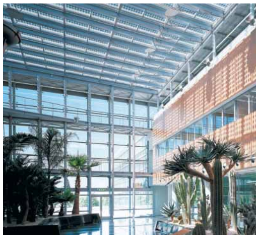
Abbildung 6 Die gebäudeintegrierte Photovoltaik der Fa. STMicroelectronics mit einer Gesamtleistung von 33 kWp wurde mit dem Schweizer Solar- preis 2003 ausge- zeichnet.
