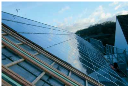
Abbildung 1a und b Die neue dachintegrierte Photovoltaik-Anlage (50,4 kWp) auf der Gesamtschule in Sehnde bei Hannover weist Abschattungen durch einen vorstehenden Anbau auf (1a). Der Effekt ist dadurch verringert worden, dass im Kernbereich der zeitweise hohen Verschattung Modulimitationen eingesetzt wurden. Zusätzlich wurden die PV-Module in Randbereichen der Verschattung in einem Strang verschaltet.
