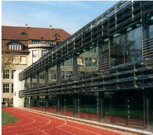
Abbildung 5a und 5b Photovoltaik-Anlage an und auf einer Schule in Stadelhofen
