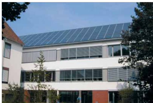
Abbildung 1a und b Die neue dachintegrierte Photovoltaik-Anlage (50,4 kWp) auf der Gesamtschule in Sehnde bei Hannover weist Abschattungen durch einen vorstehenden Anbau auf (1a). Der Effekt ist dadurch verringert worden, dass im Kernbereich der zeitweise hohen Verschattung Modulimitationen eingesetzt wurden. Zusätzlich wurden die PV-Module in Randbereichen der Verschattung in einem Strang verschaltet.
