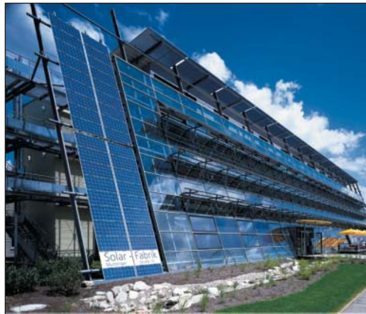
Architektur: Werkgemeinschaft Maier-Weinbrenner-Single, Nürtingen. Energiekonzept: Fraunhofer ISE, Messung: Hochschule für Technik, Stuttgart
