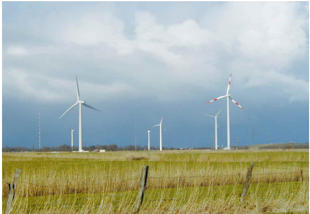
Abbildung 7 DEWI Windenergie- Testfeld nördlich von Wilhelmshaven mit Anlagen der Megawatt-Klasse und Messmasten
