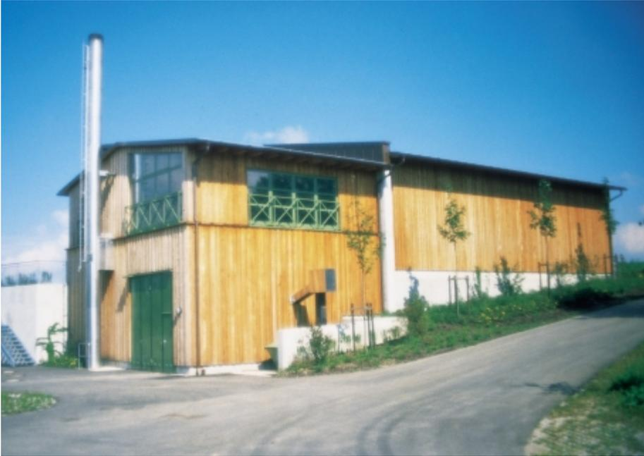
Abbildung 2: Das Biomasseheizwerk im Neubaugebiet „Obere Rottach“ des Luftkurortes Buchenberg – erstes Modellprojekt im Allgäu (850 kW Biomassekessel für Grundlastbetrieb; drei Heizölkessel von 2 x 350 und 230 kW für Spitzenlast und Notbetrieb). Im Endausbau substituiert das Heizwerk jährlich 230.000 Liter Heizöl.
