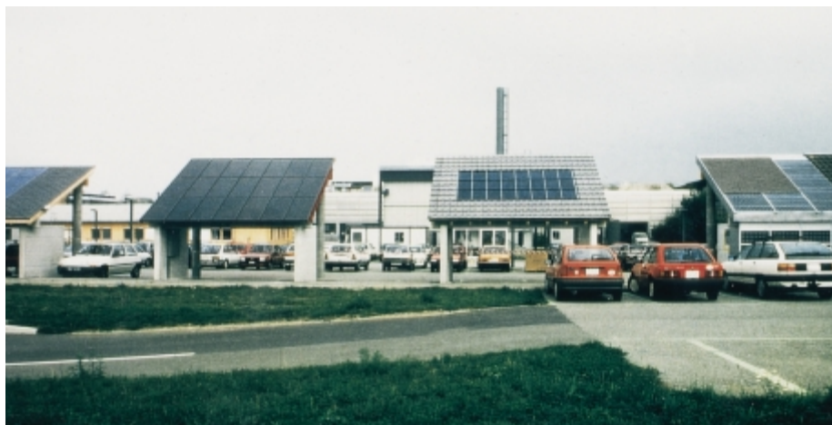
Abbildung 1: Auf dem Gelände der Technischen Hochschule Lausanne werden verschiedene Methoden zur konstruktiven Integration von PV-Modulen in Gebäude ausgestellt.
