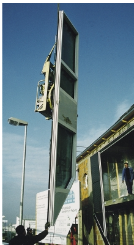
Abbildung 3: Ein einbaufertiges Fassadenelement wird in den Rohbau eingehängt (Solarzentrum Freiburg).
