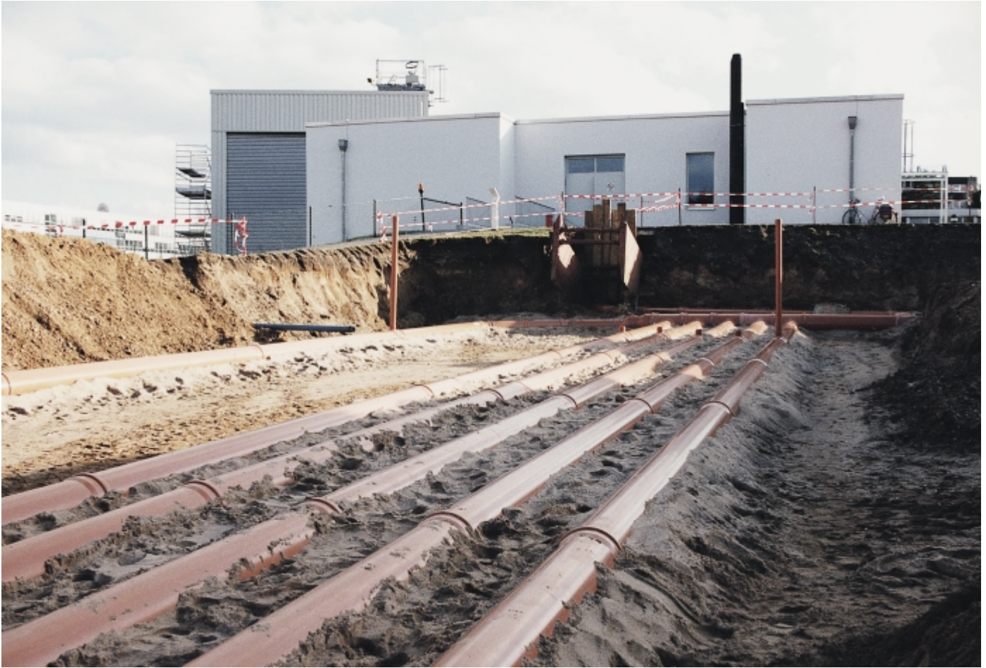
Abbildung 4: Im Vordergrund ist ein Teil des EWT während der Bauphase zu sehen; im Hintergrund das Sonnenofen-Laborgebäude.
