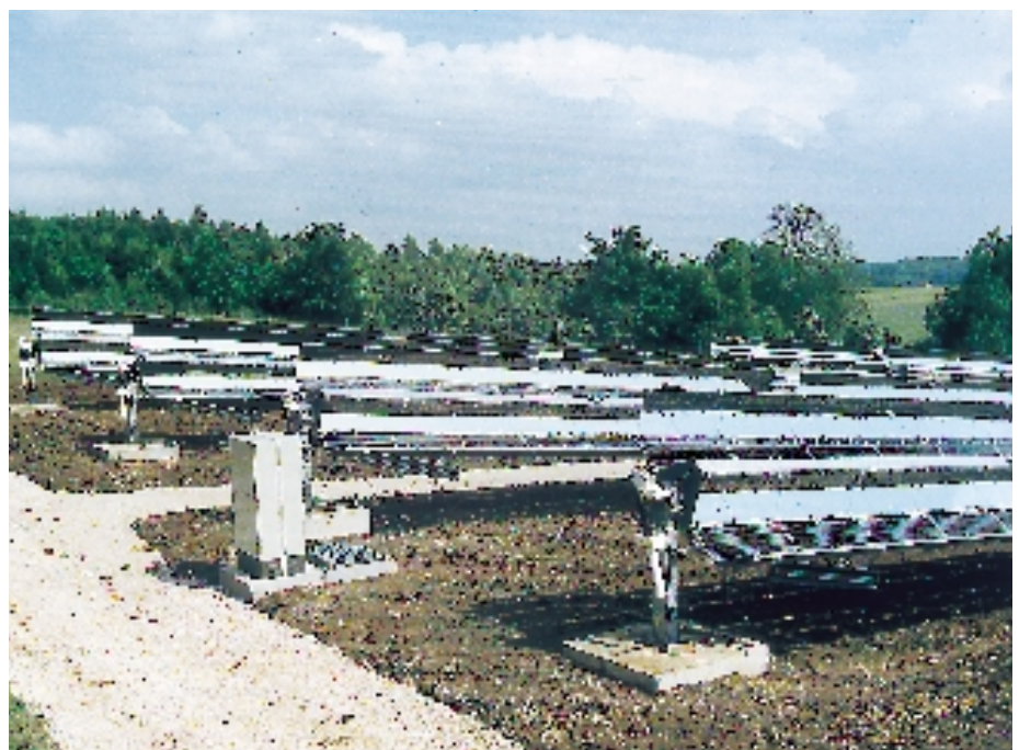
Abbildung 6: PV V-Trog Anlage auf dem ZSW Solartestfeld in Widderstall/Schwäbische Alb. Die Anlage besteht aus 9 Teilsystemen mit je 2,72 kW p installierter PV Modulleistung.
