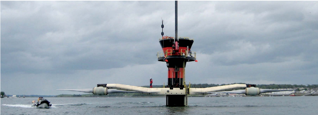
Gezeitenströmungskraftwerk „SeaGen“, Leistung 1,2 MW Quelle: Fraunhofer IEE
