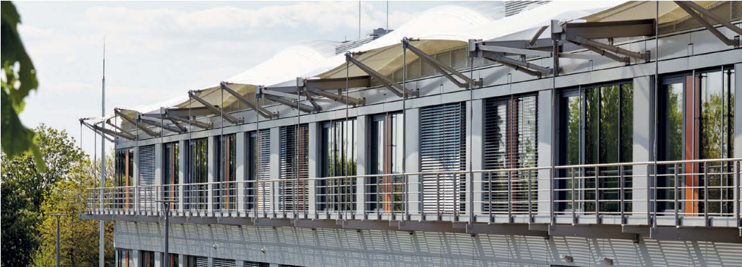
Forschungs- und Demonstrationsgebäude mit transluzentem textilem Dach, evakuierten Wärmedämmsystemen sowie innovativen Sonnenschutzeinrichtungen. © ZAE Bayern Foto: Petra Höglmeier
