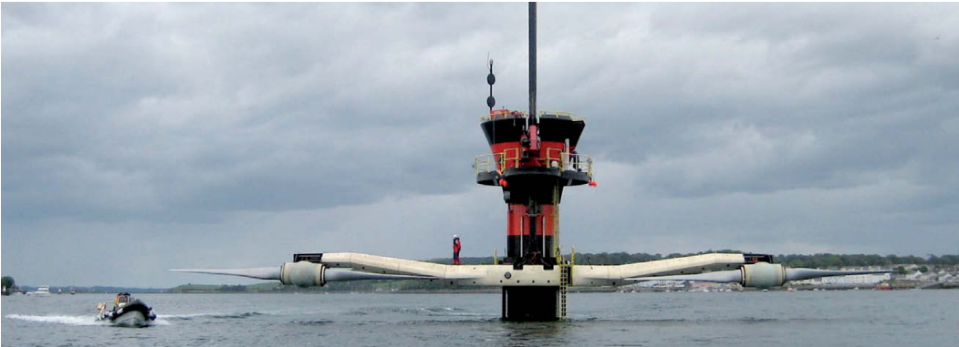
Gezeitenströmungskraftwerk „SeaGen“, Leistung 1,2 MW Quelle: Fraunhofer IWES
